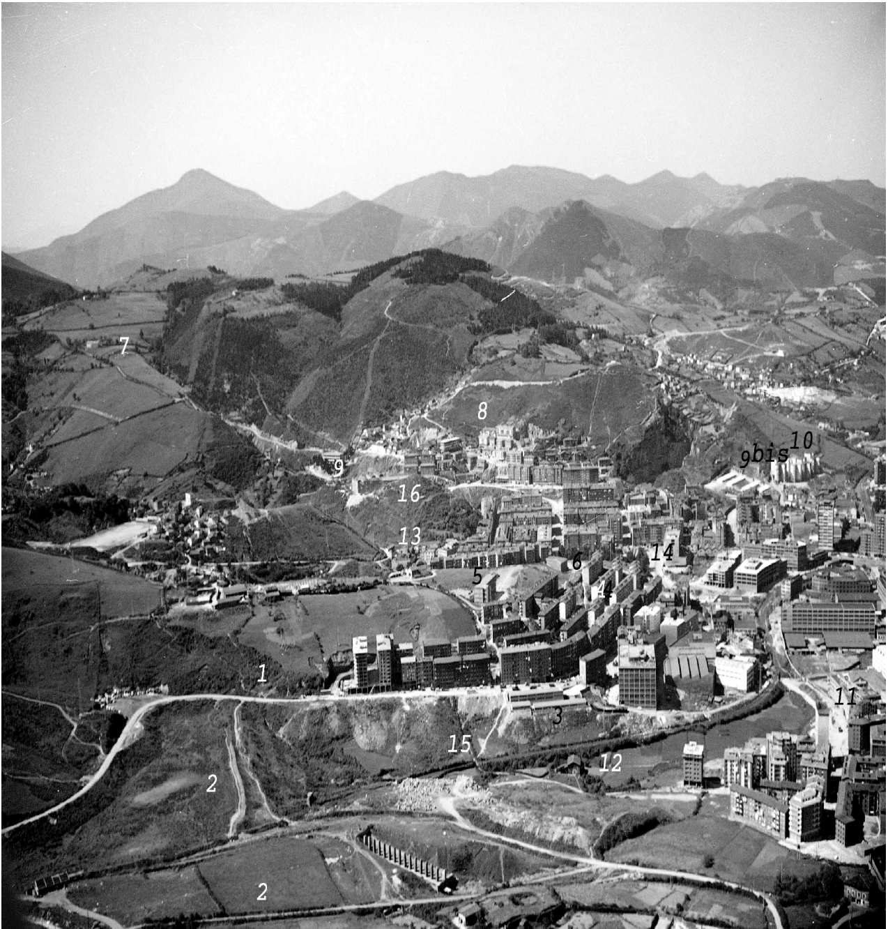
Vista panorámica de la Carretera de Rekalde a Larraskitu.F0to Ikatz
