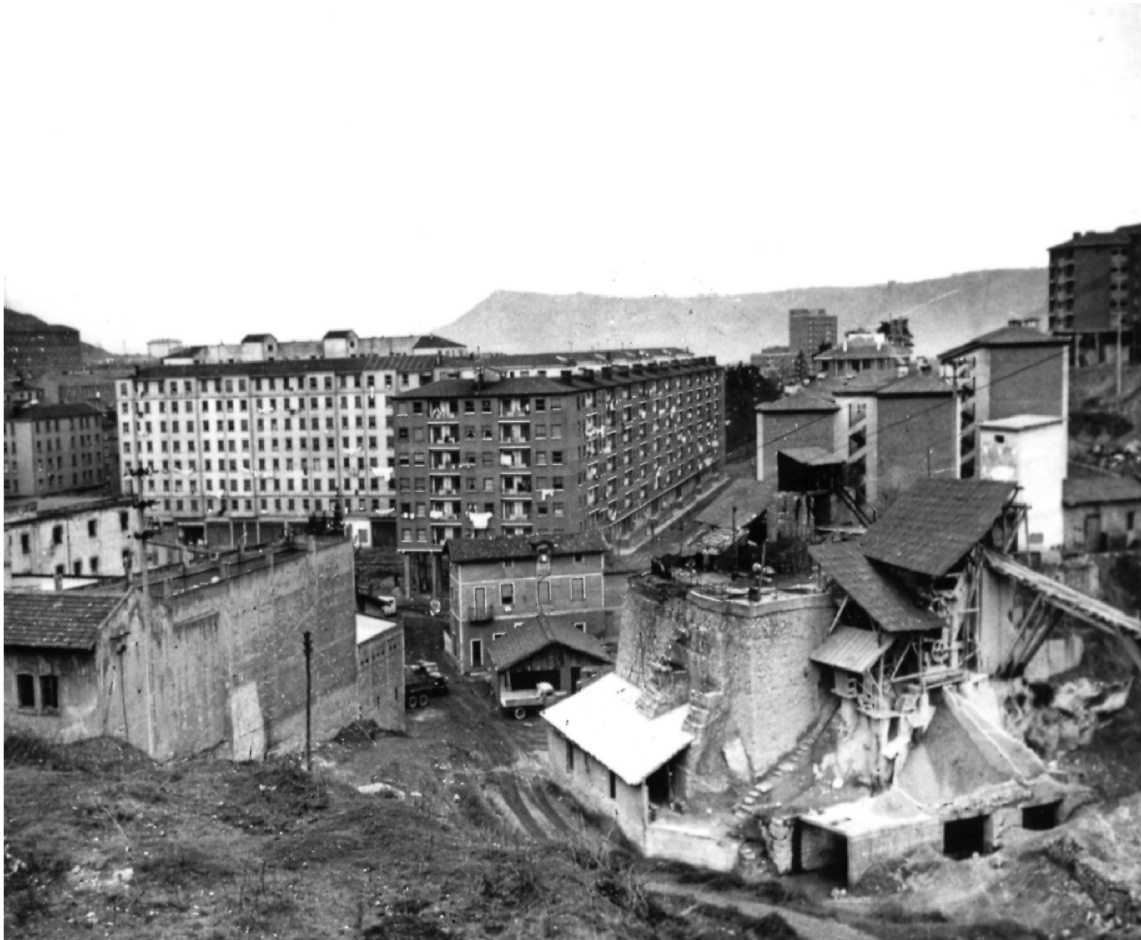
Viviendas en calle Bizkargi y calle Esperanto, al final de Gordóniz, tras antiguos caseríos, la Cervecera de Iturrigorri y horno para cal de las canteras de Gaztelondo. (Foto Montón)
