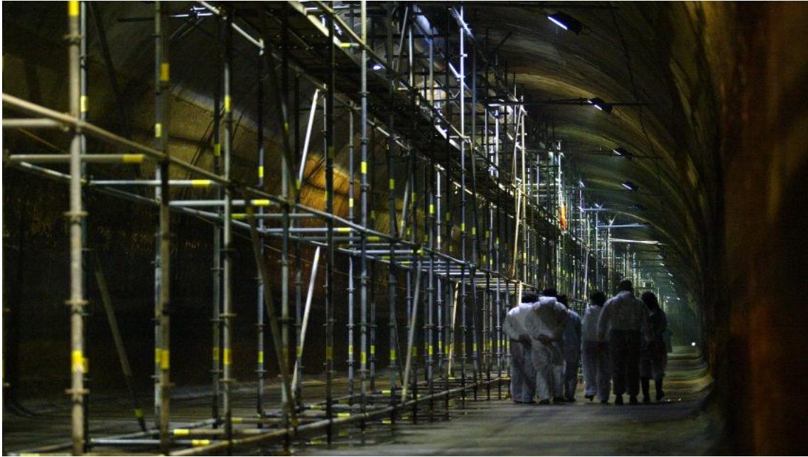
2008. Túnel bajo el Monte Caramelo del aljibe de Elejabarri. La noticia decía que tras 80 años, el Ayuntamiento comenzaba a practicar una limpieza anual del Depósito, en el que se habían acumulado lodos en el suelo y estalactitas en el techo durante tantos años. (Fotos: Correo)
