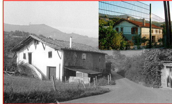
Caserío Makotxune en foto de A. Casal, hacia 1960 y su rehabilitación posterior, en 2003.
