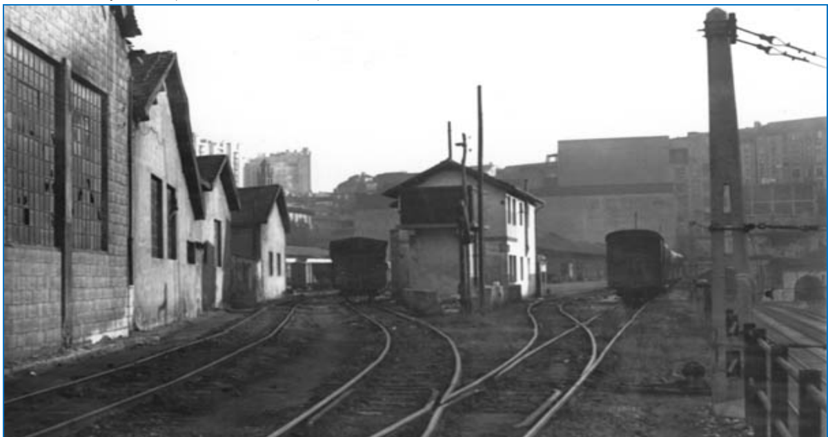
1960. Al otro lado del puente. Al fondo, rascacielos de Zabálburu e Irala. En primer término, vías de Ametzola para depósito de mercancías y material. Sobre este espacio se alzan la Estación de Ametzola, el Parque y las urbanizaciones que se alinean entre las calles Santiago Brouard y Dolores Ibarruri. (Foto: Albino Casal)
