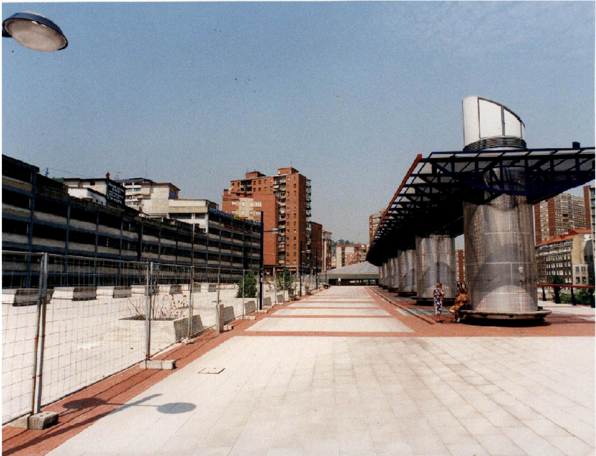
Sobre el antiguo “mar de vías”, la nueva estación y los modernos edificios de Ametzola: Rekaldeberri, más unido a Bilbao.
