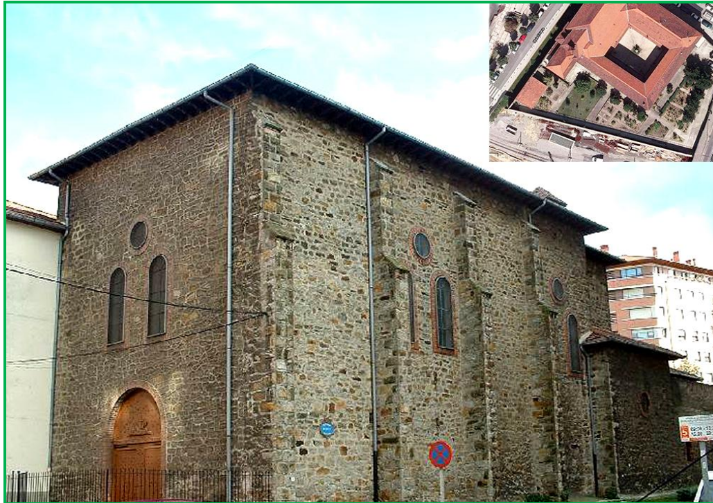
Iglesia de las Madres Capuchinas, con pórtico austero a la calle Novia de Salcedo. Arriba, vista aérea de la manzana del convento. Se observan las obras que realizó el ayuntamiento para alargar la calle Jardín Txikerra, tras Iglesia de las Madres Capuchinas. Arriba, vista aérea de la manzana del convento. Se observan las obras que realizó el ayuntamiento para alargar la calle Jardín Txikerra, tras expropiar en 2008, 425,83 mts2 al convento de capuchinas.
