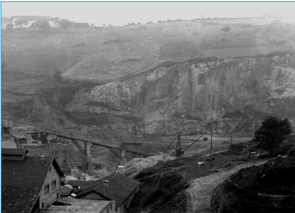
1940, aprox. Zona de Gaztelondo cuando era una cantera, desde Camino de Aluceta, con la trasera del edificio de La Cervecera a la izquierda y los tinglados de la Cantera Salcedo, donde se fabricaba cal y se molía piedra, en el centro de la imagen. Por las cimas de Artatzu, los caseríos Behekoa y Goikoa o de Gumer.
